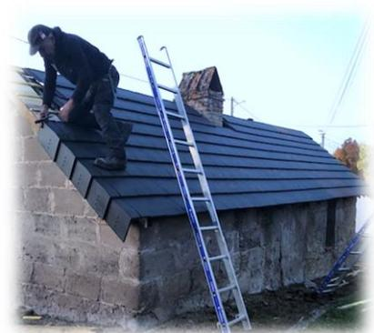
L'entreprise Bambou a réparé la charpente et changé les tuiles du vieux four, Route de Cublac. Une réhabilitation de l'intérieur est prévue pour une utilisation future.
