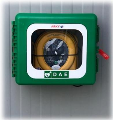
Un défibrillateur a été installé par M. Bruneau au Mille-club. Il est positionné dans une boîte ventilée, chauffée et munie d'un dispositif d'alarme sonore.
