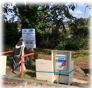
Un coffret électrique est opérationnel à côté de la maison communale, Place du 19 mars. Il est équipé de 4 prises de 220 volts et d'1 prise de 380 volts. Il pourra être utilisé lors des prochaines festivités.
